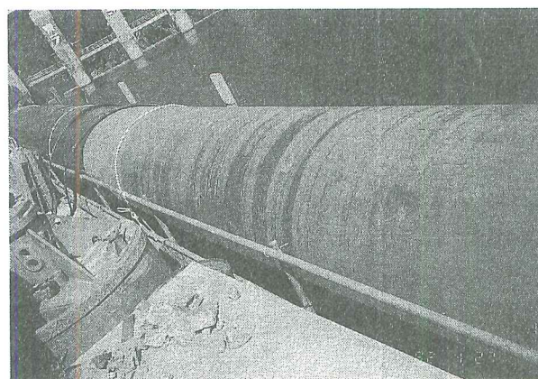
写真-9 建込み用φ1,500mm鋼管。左側の黒褐色に塗装されている部分は、根固め用防蝕用樹脂コーティング（構台上には鋼管を仮置する適当なスペースがないため湖水側に張出し部を設けた）
