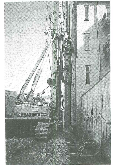
写真-7 BG30によるオールケーシング柱列壁施工状況
