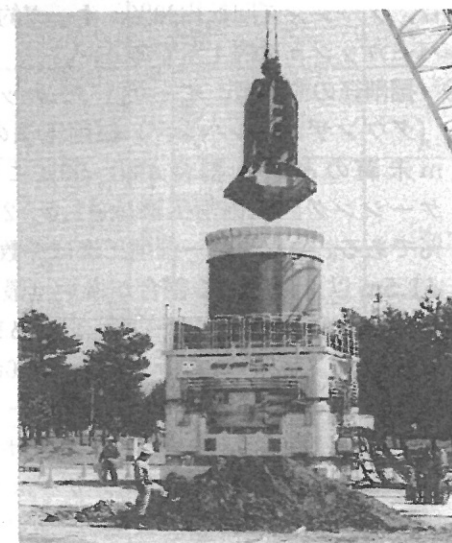
写真-2 全回転式オールケーシング機MT410RSおよび3m³ハンマグラブ全景
