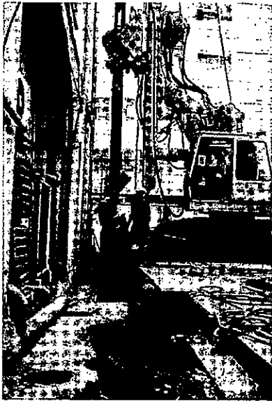
写真-1 BG工法施工状況
