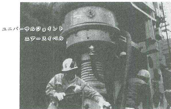
写真-3 ユニバーサルジョイント(h)とエアースイベル(f)がパワーロータリーヘッドに直接装着されている
