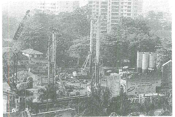
写真-4 場所打ち杭の施工状況
