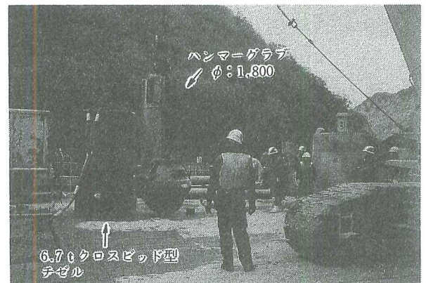
写真-5 ローラービット削孔後の中掘り用ツール
